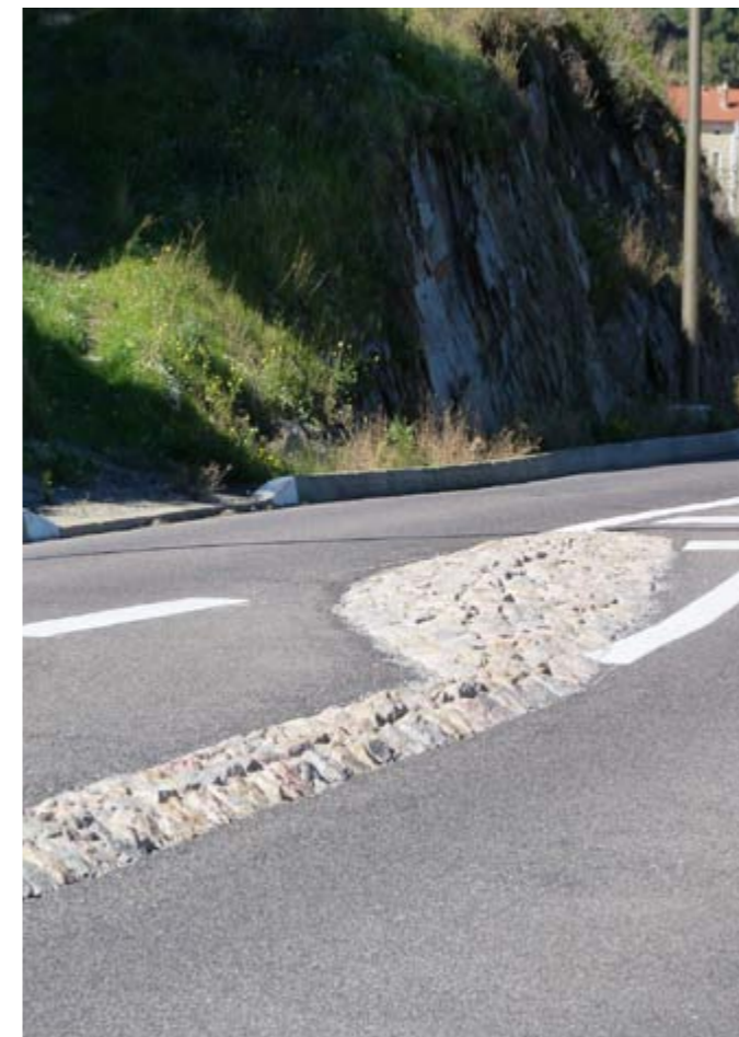
Tratamento de piso com 'rasgos' de pedra. Indicam recuo central, lateral ou parada estratégica.
